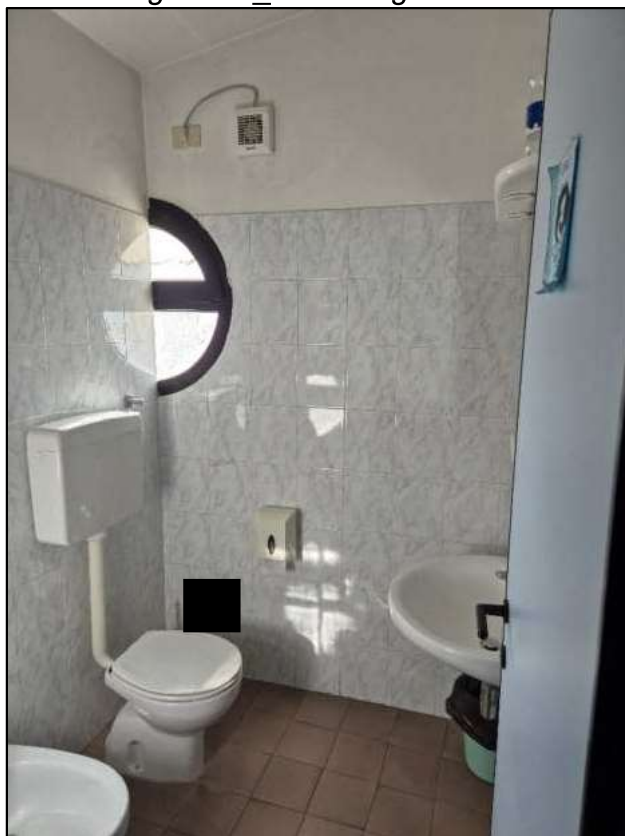
Fotografia 6_ Vista Bagno Donne.
